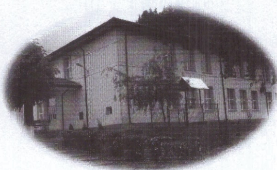
Școala Primară Schitu-Frumoasa – structură
